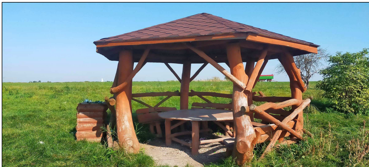
Fot.3 Altana przeznaczona do naprawy i konserwacji oraz uzupełnienia w nowy stół i ławki (źródło: inwentaryzacja z dnia 26-09-2023r.)
