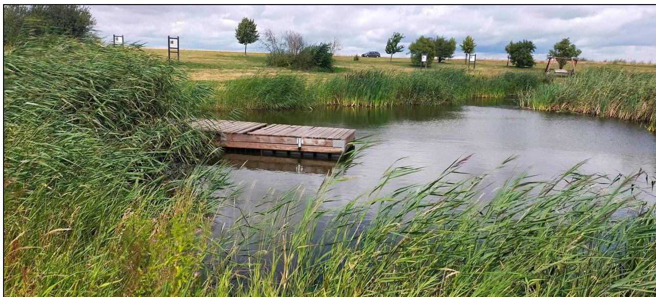
Fot.2 Widok na staw od strony południowej - widoczny jest pomost pływający wymagający naprawy i konserwacji (źródło: inwentaryzacja z dnia 23-07-2023r.)
