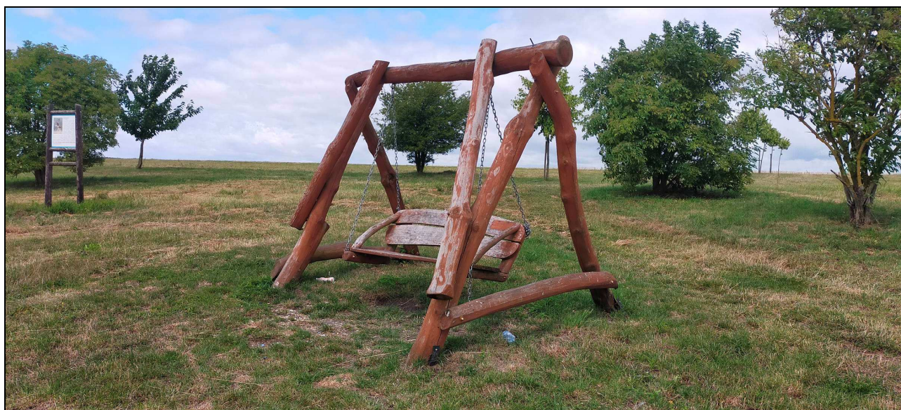
Fot.4 Ławka / huśtawka przeznaczona do demontażu / wymiany na nową (źródło: inwentaryzacja z dnia 23-07-2023r.)
