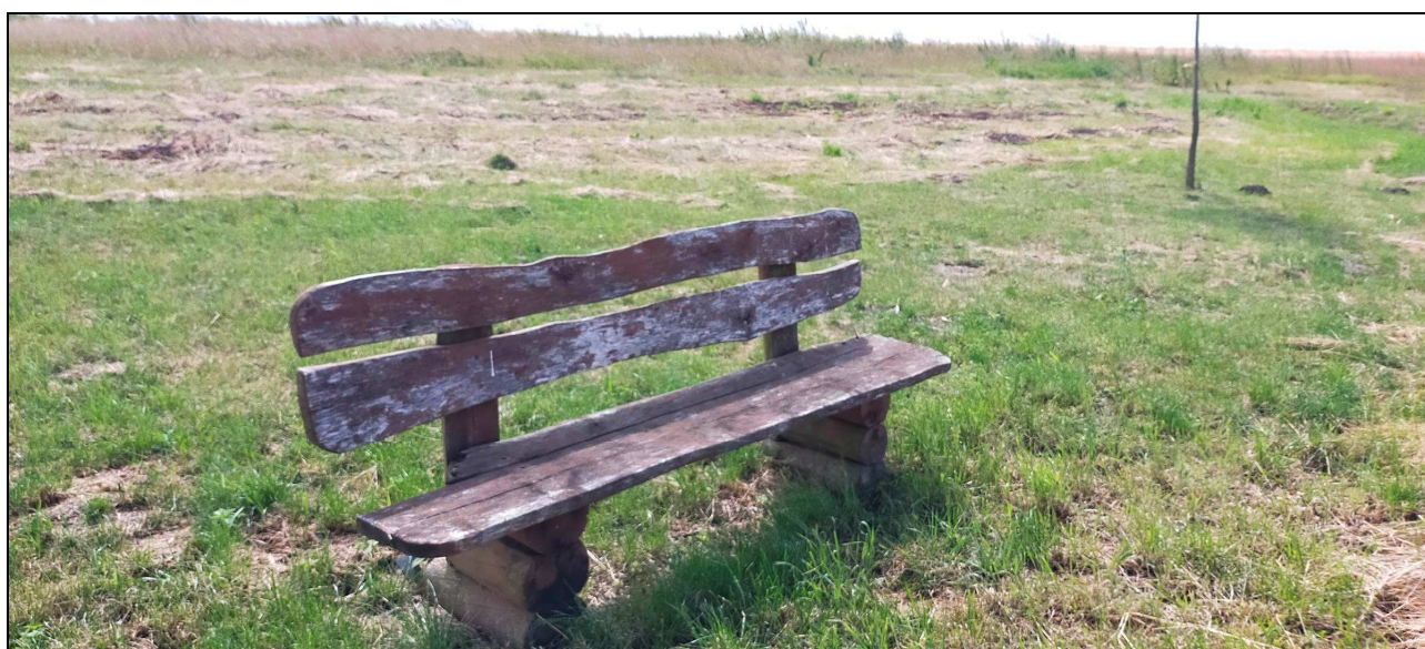
Fot.8 Jedna z ławek przeznaczonych do demontażu (źródło: inwentaryzacja z dnia 23-03-2023r.). Niestety we wrześniu 2023 stwierdzono znaczne pogorszenie stanu technicznego wszystkich ławek i zdecydowano o ich demontażu.
