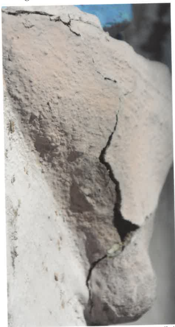
Fot. nr 3, 4. Pęknięcia i rysy rozdzielcze.
