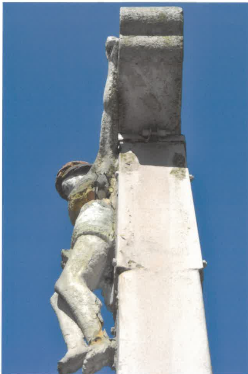
Fot. nr 9. Chropowatość powierzchni oraz czarne niejednorodne nawarstwienia widoczne na figurze Chrystusa.
