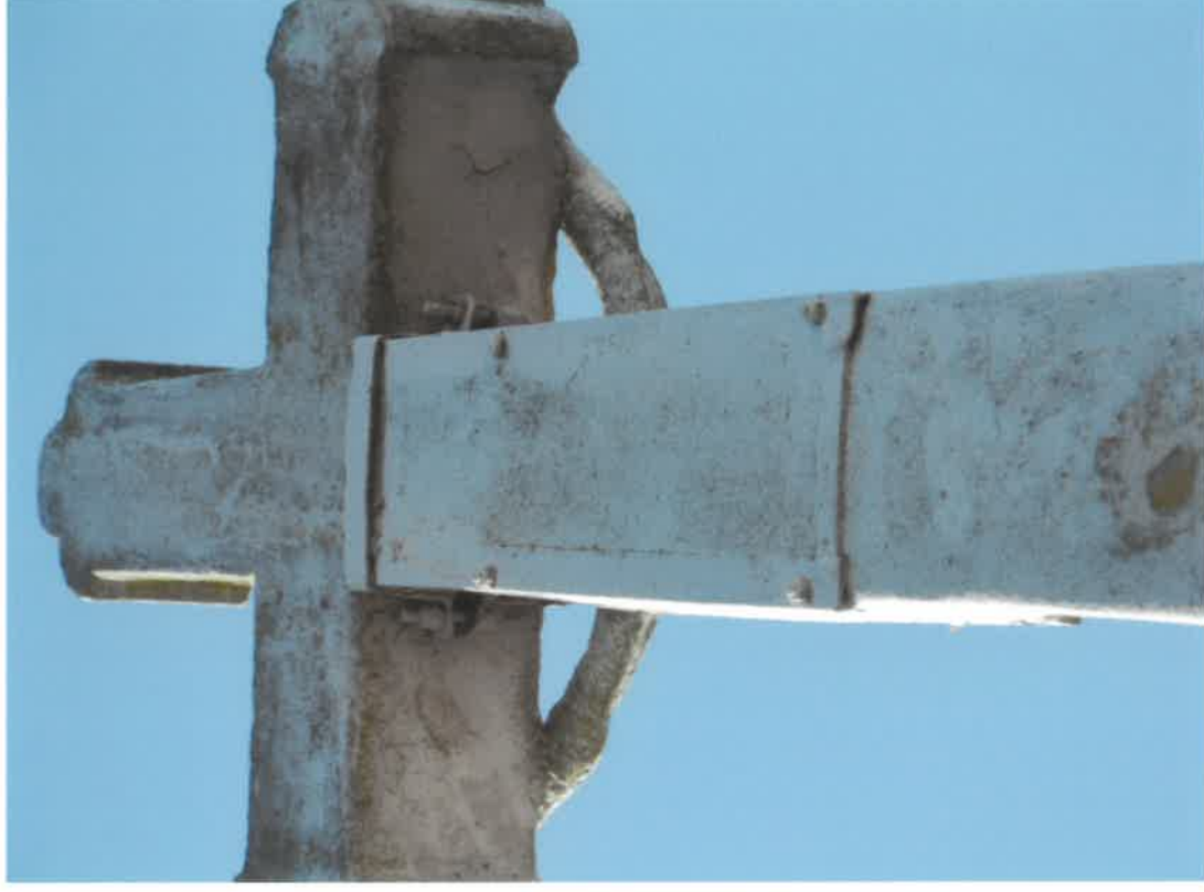
Fot. nr 23. Krzyż przydrożny zlokalizowany w miejscowości Kobiór przy ulicy Przelotowej. Metalowe płaskowniki spingiące krzyż. Stan zachowania przed konserwacją.
