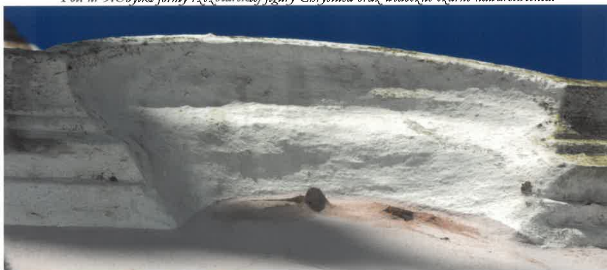
Fot. nr 6. Ubytki profili w arkadowej wnęce kapiteła, pokryte wtórnymi warstwami malarskimi.
