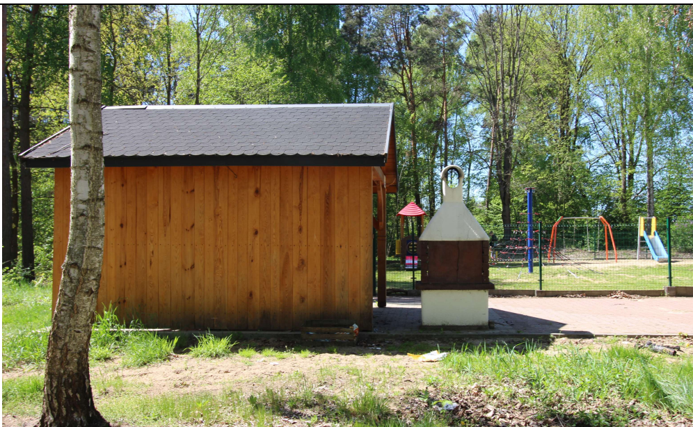
Fot. 2. Istniejąca wiata do demontażu i grill betonowy wolnostojący do przestawienia
