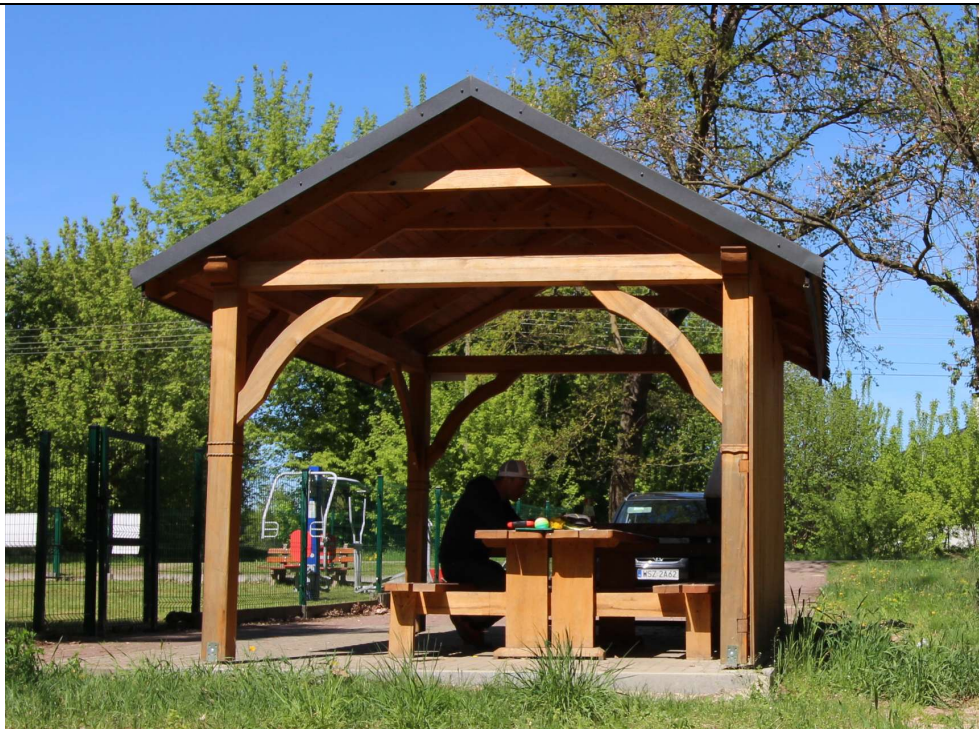
Fot. 1. Istniejąca wiata do demontażu
