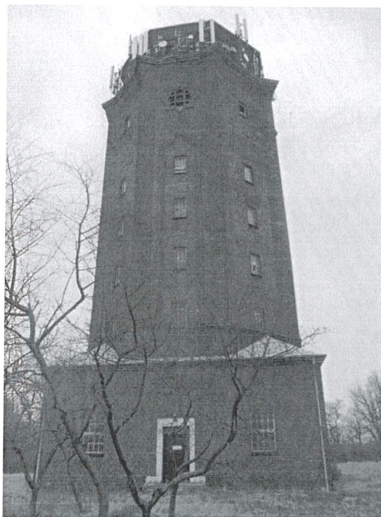
Zał. nr 1: Widok ogólny instalacji radiokomunikacyjnej.
