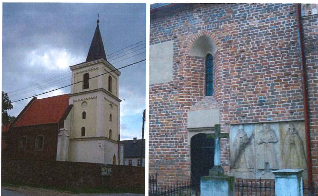
Fot.P1 Widok elewacji północnej budynku kościoła oraz elewacja wschodnia z zabytkowymi drzwiami
