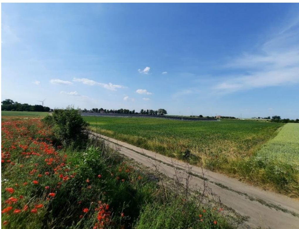
Ryc. 3. Widok na instalację fotowoltaiczną z odległości ok. 150 m. Na fotografii występuje efekt skumulowania farmy fotowoltaicznej z elektrownią wiatrową.
