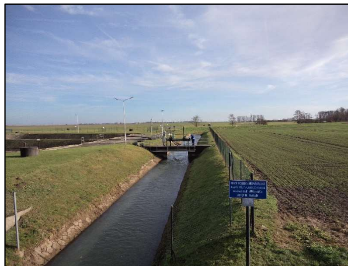
Fot. 39 Kanał Pępicki Potok, widok na południe z DW 401
