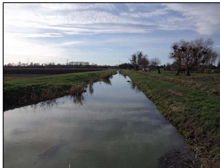
Fot. 19 Kanał Nysa Kłodzka – Oława w Michałowie, widok w kierunku zachodnim
