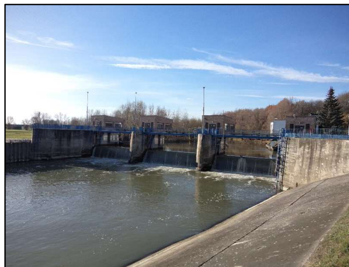
Fot. 4 Jaz na Nysie Kłodzkiej, element kanału Nysa Kłodzka - Oława
