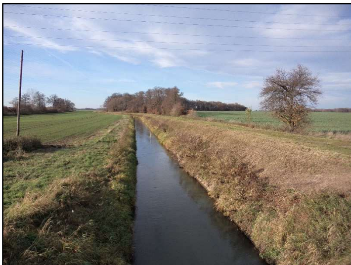
Fot. 38 Kanał Pępicki Potok, widok na północ z DW 401
