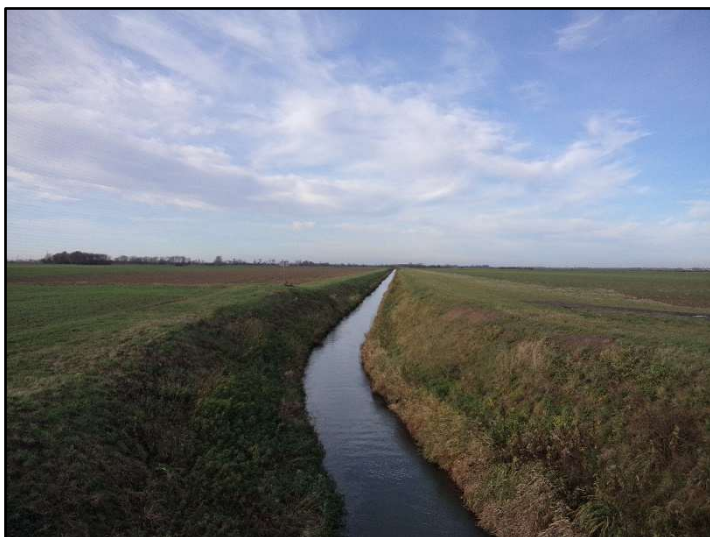
Fot. 25 Kanał Pępicki Potok z drogi łączącej Pogorzelę z Michałowem, widok w kierunku zachodnim
