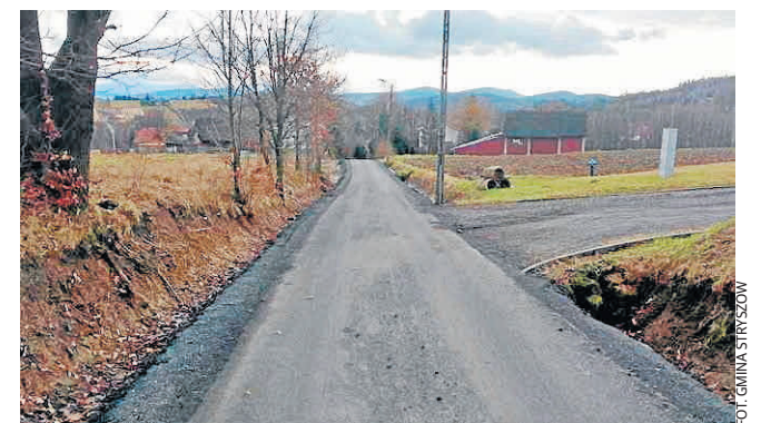
Wyremontowana droga w Łękawicy
