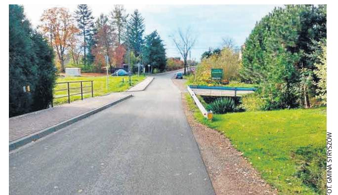
Przebudowana droga Łękawica - Zagórze
