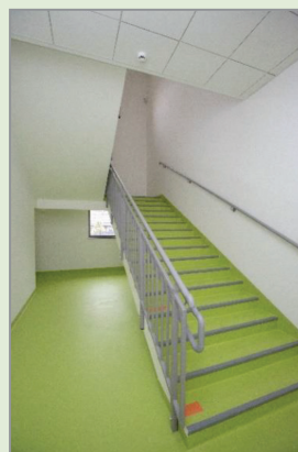
Schody prowadzące na piętro
