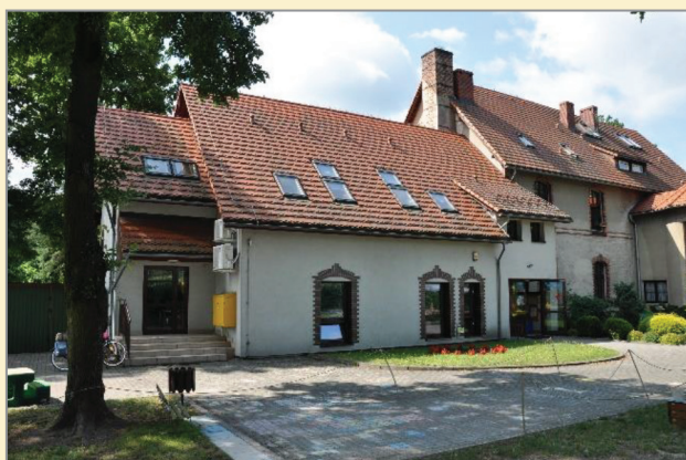
Fot. Nadbudowane nad kotłownią z 1987 r. poddasze z salą dydaktyczną i wejściem ewakuacyjnym - 2009.
