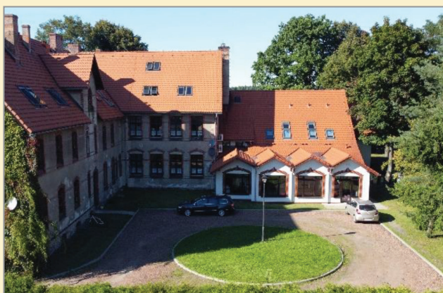
Fot. Dodatkowa sala dydaktyczna oddana w 2017 r. z gabinetem logopedycznym (dach wielospadowy z trzema koszami rynnowymi).
