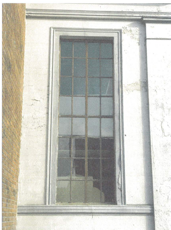
widok okna krosnowego w elewacji szczytowej – widok obecny okno 32-polowe
