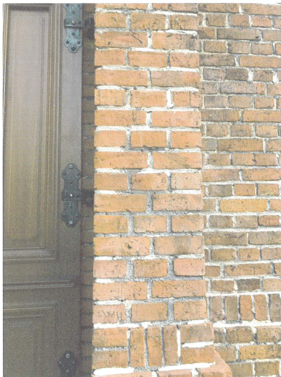
portal wejściowy widok stanu spoinowania cegły elewacyjnej
