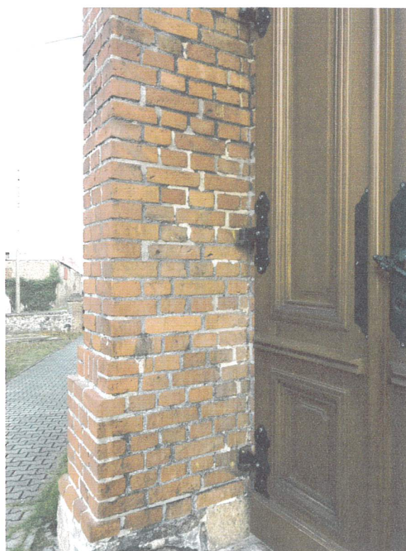
portal wejściowy widok stanu spoinowania cegły elewacyjnej
