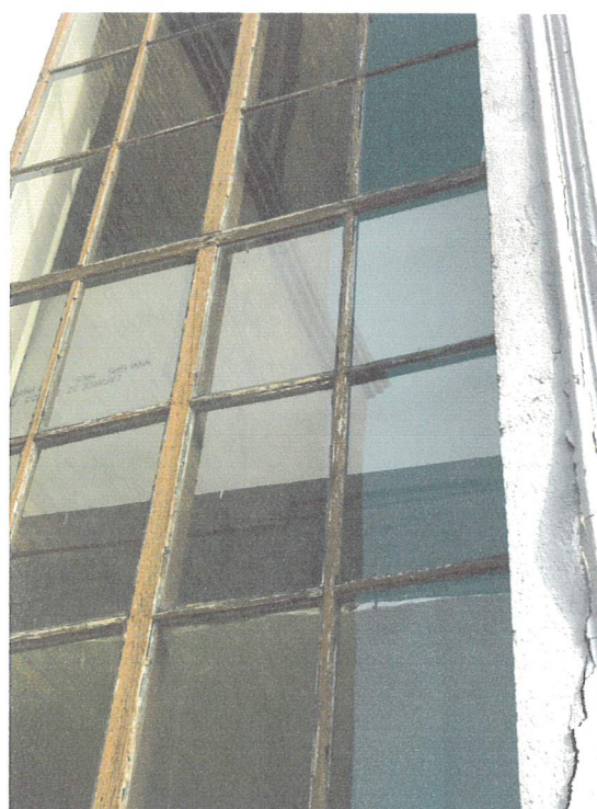
widok okna krosnowego w elewacji szczytowej – widok obecny okno 32-polowe
