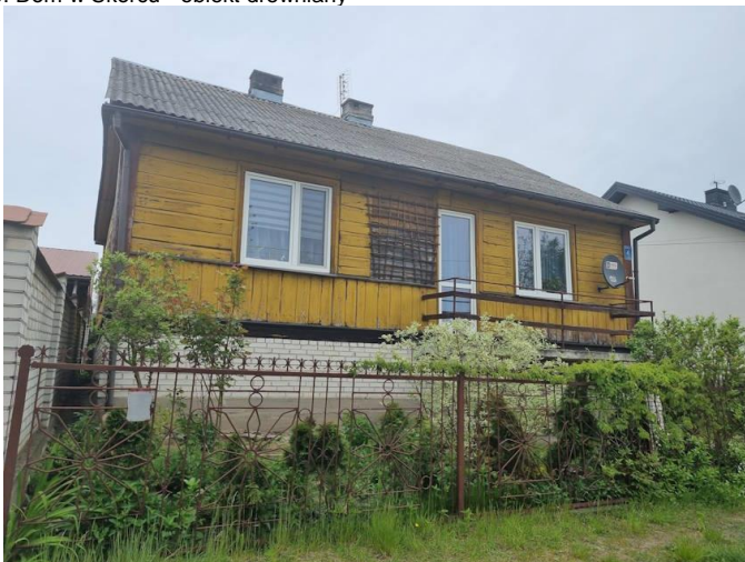
Fotografia 20. Dom w Skórcu - obiekt drewniany
