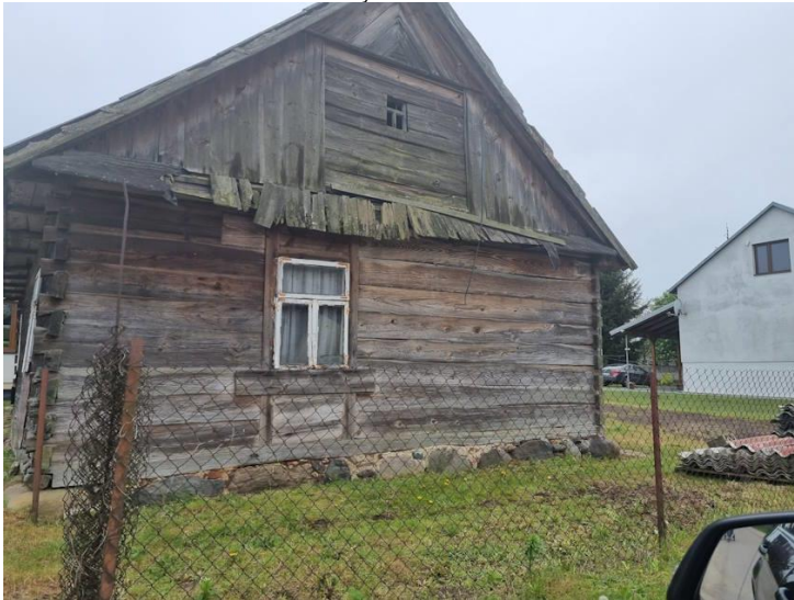
Fotografia 19. Dom w Skórcu - obiekt drewniany
