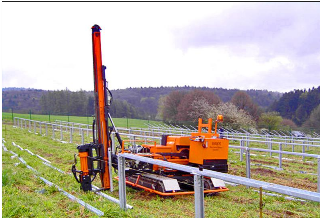
Rysunek 15. Maszyna wciskająca konstrukcje stalowe w grunt.
