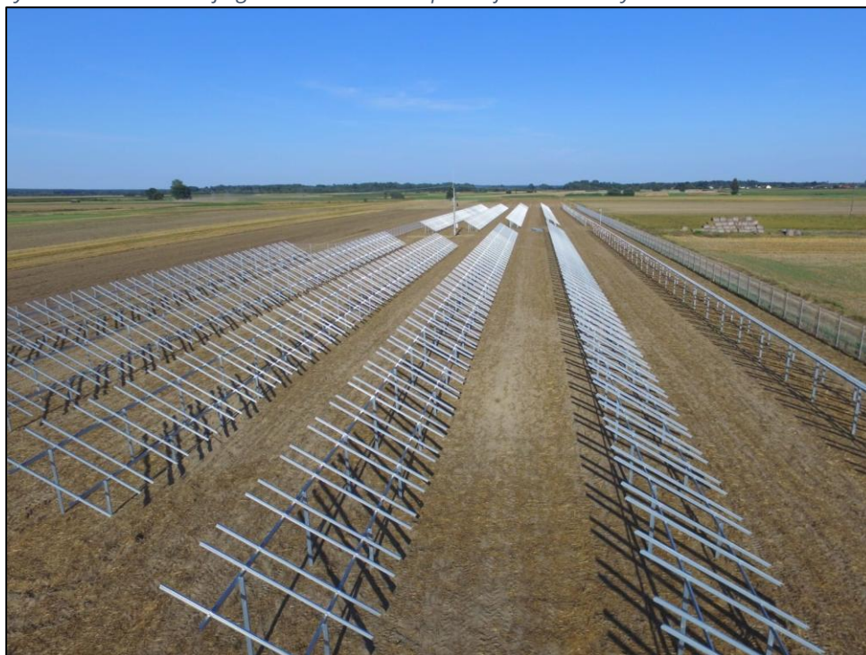
Rysunek 16. Konstrukcja gotowa do montażu paneli fotowoltaicznych.
