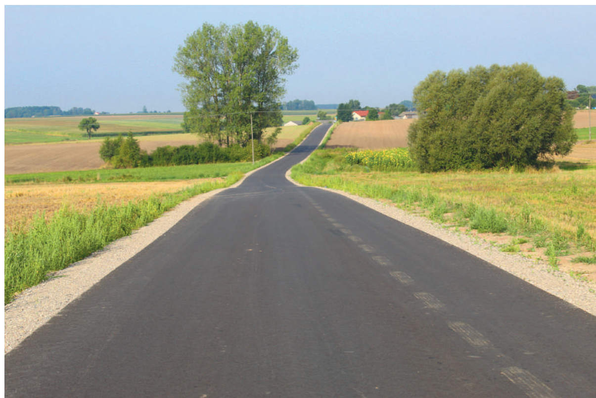
Przebudowa drogi na odcinku Szkopy – Borychów
