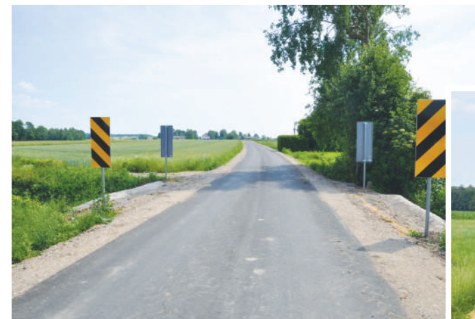
Przebudowa drogi wewnętrznej w miejscowości Ostrówek
