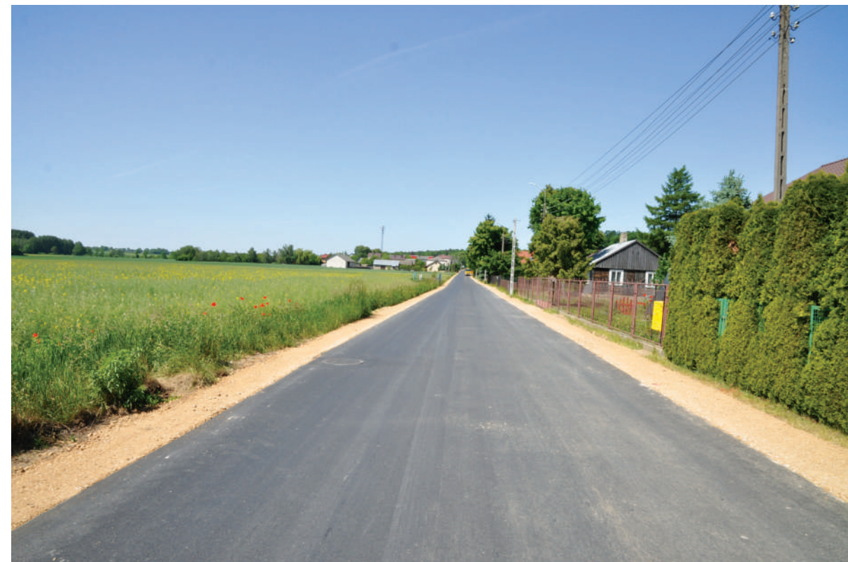
Przebudowa drogi w miejscowości Repki ul. Orzechowa
