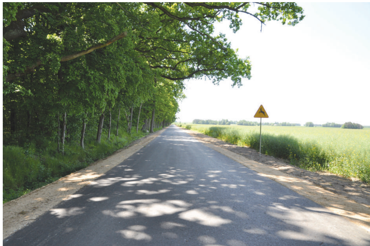
Przebudowa drogi na odcinku Repki od Zakładu Rozbioru do drogi krajowej
