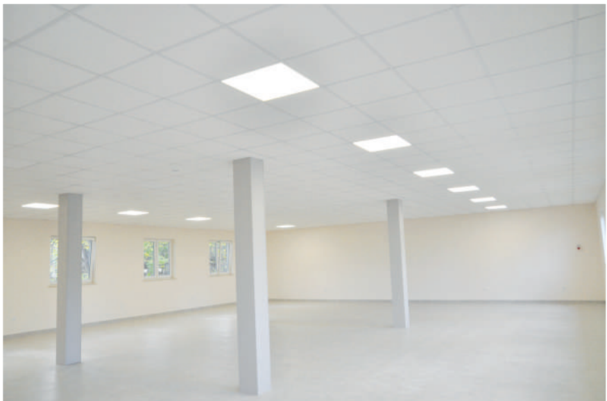
Modernizacja budynku świetlicy wiejskiej w Rudnikach
