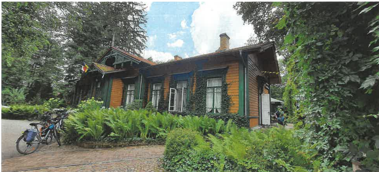
Fot. 1. Widok istniejącego budynku Restauracji Carskiej w Białowieży – widok od strony północnej (od strony ul. Stacja Towarowa)
