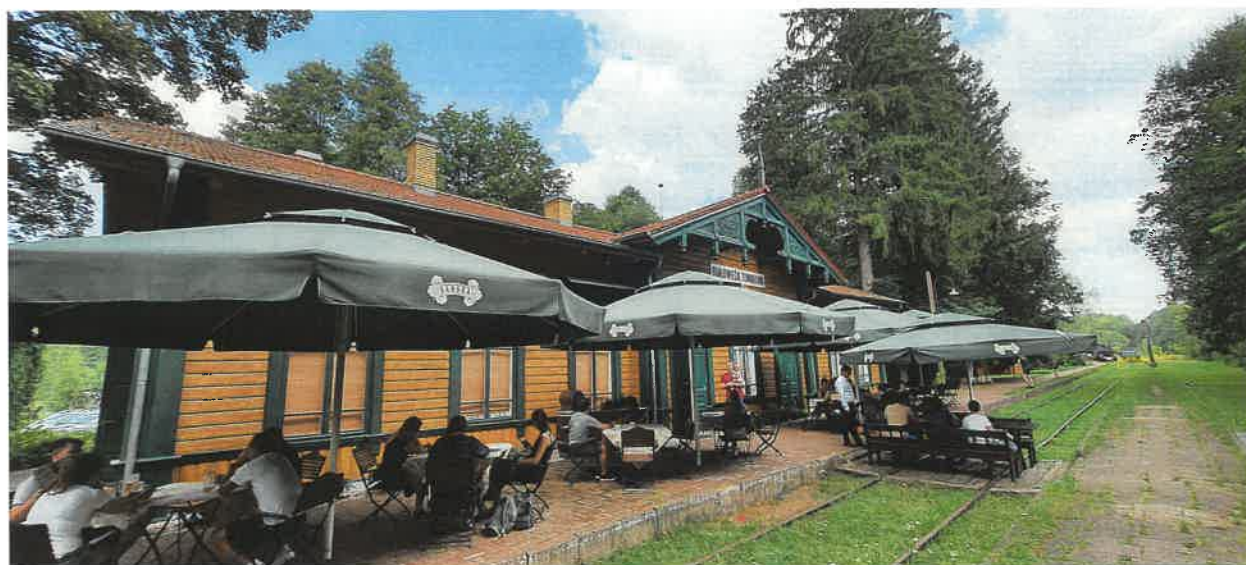
Fot. 6. Widok istniejącego budynku Restauracji Carskiej w Białowieży – widok od strony zachodniej (od strony byłego peronu)
