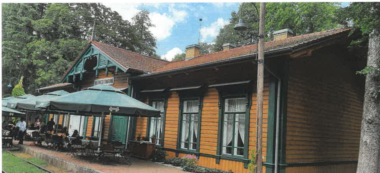
Fot. 5. Widok istniejącego budynku Restauracji Carskiej w Białowieży – widok od strony południowej (od strony byłego peronu)
