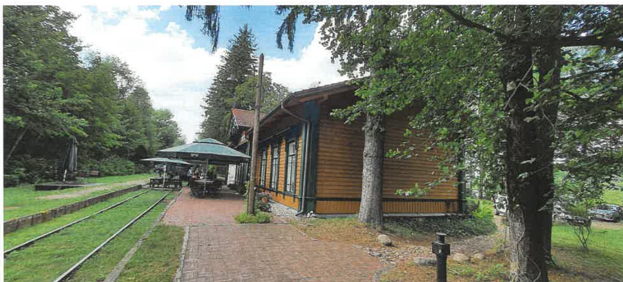
Fot. 4. Widok istniejącego budynku Restauracji Carskiej w Białowieży – widok od strony południowej (od strony byłego peronu)
