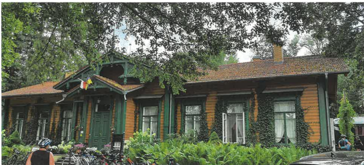
Fot. 2. Widok istniejącego budynku Restauracji Carskiej w Białowieży – widok od strony północnej (od strony ul. Stacja Towarowa)
