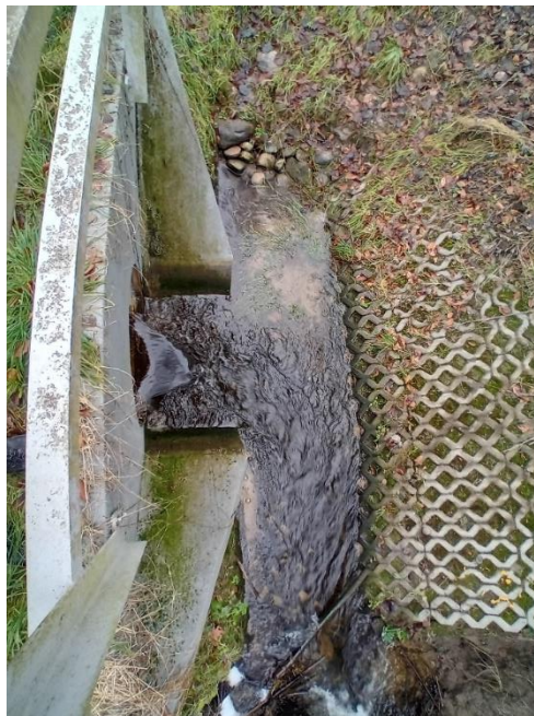
Zdjęcie nr 2 - Widok betonowego wylotu.
