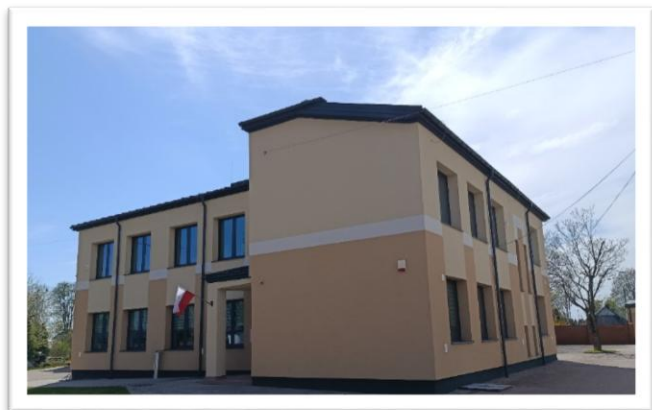
Termomodernizacja budynku Gminnego Centrum Czytelnictwa i Kultury- Poprawa efektywności energetycznej
