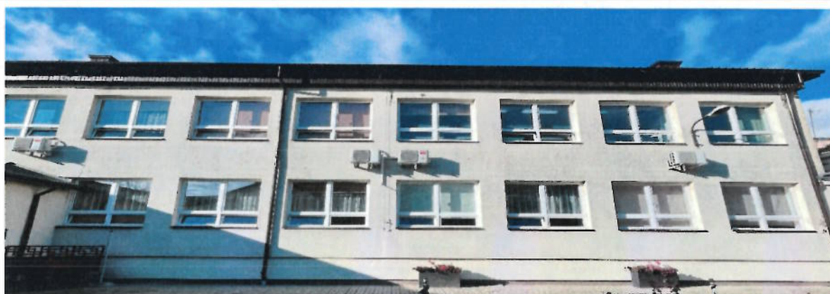
Nowe okna i klimatyzatory w ZSP w Sobolewie
