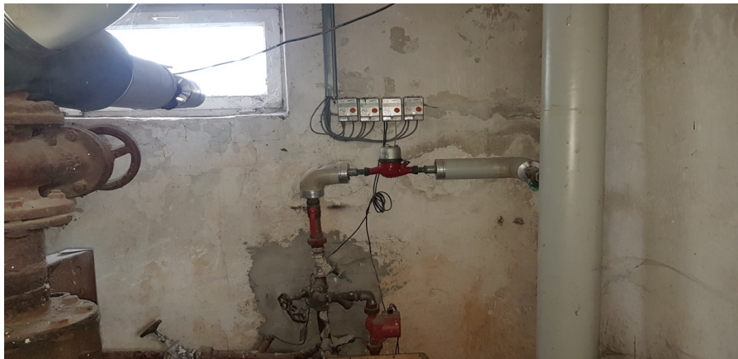
Fot. 4 Przyłącze do jednego z obsługiwanych budynków sieci ciepłowniczej w podpiwniczeniu UG
