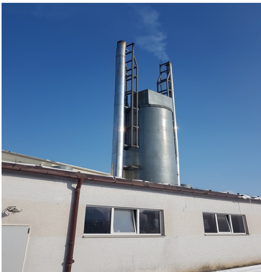
Fot. 3 Widok na kotłownię z instalacją kominową i buforem ciepła
