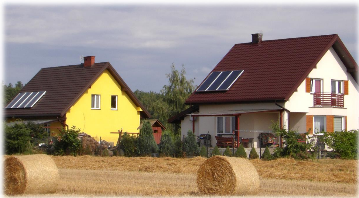
Instalacje solarne na indywidualnych gospodarstwach domowych
