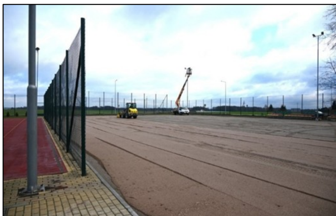
Zdjęcie 20 Remont boiska Orlik
