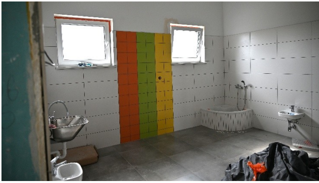
Zdjęcie 26 Budowa żłobka
