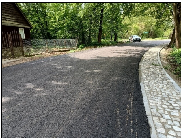
Zdjęcie 12 Remontowana droga gminna
