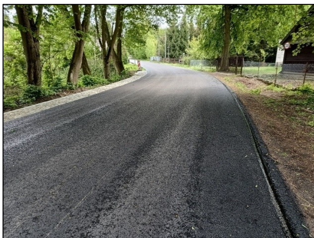
Zdjęcie 10 Remontowana droga gminna
