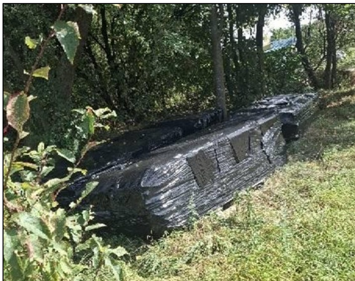
Zdjęcie 32 Zabezpieczony eternit
