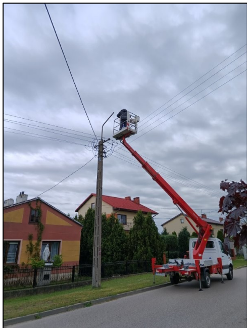
Zdjęcie 9 Montaż oświetlenia
