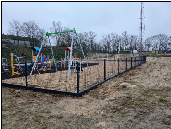
Zdjęcie 27 Plac zabaw w Gostchorzy podczas budowy
