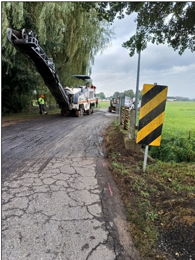
Zdjęcie 13 Prace modernizacyjne na drodze gminnej
