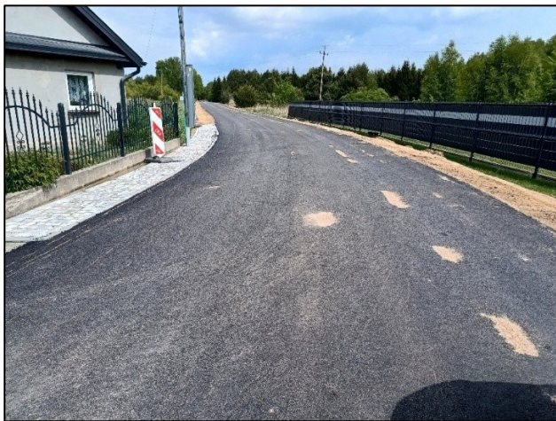
Zdjęcie 11 Remontowana droga gminna
