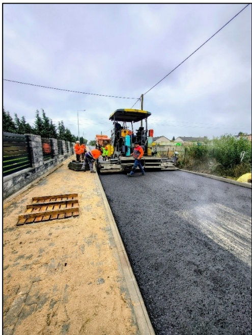
Zdjęcie 15 Budowa ulicy w miejscowości Wiśniew
