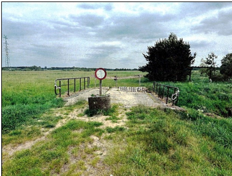
Zdjęcie 14 Most przeznaczony do rozbiórki
