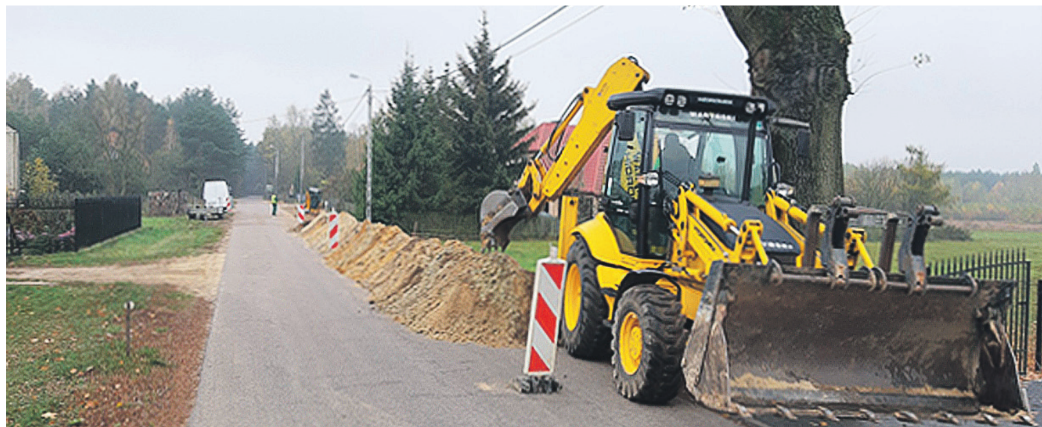
Budowa kanalizacji sanitarnej w Białymbłocie
