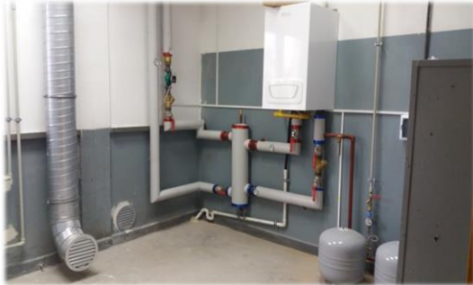
Modernizacja kotłowni w budynku praktycznej nauki zawodu przy Zespole Szkół w Różanie
