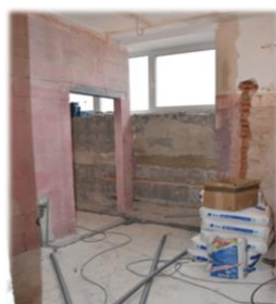
Rozbudowa i modernizacja budynku Liceum Ogólnokształcącego w Makowie Mazowieckim
