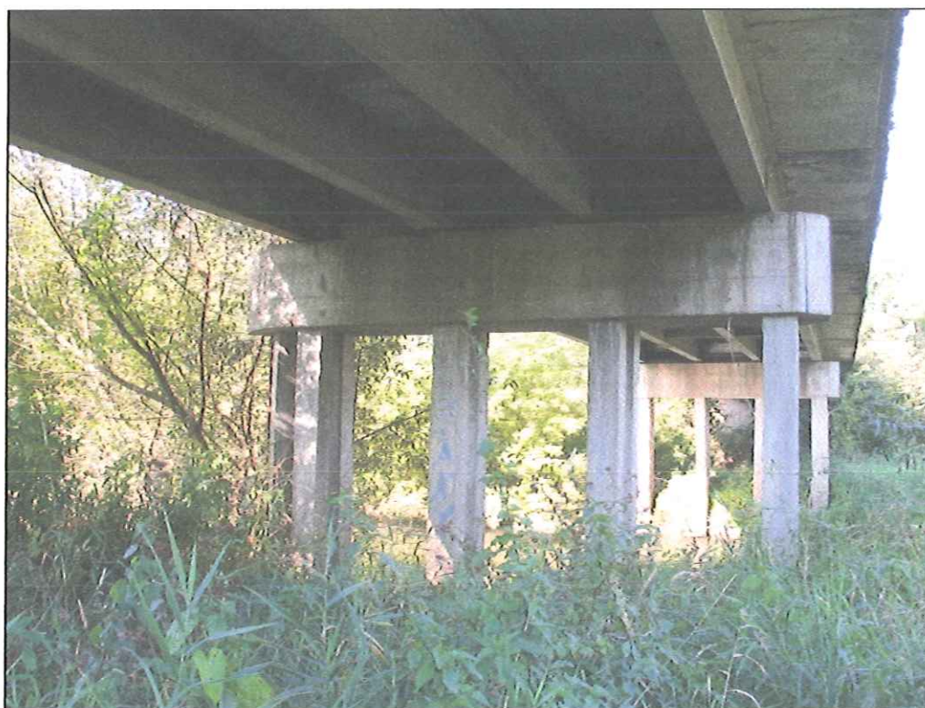
Fot. 4. Spód ustroju nośnego z widokiem na podporę pośrednią Nr 3 od strony m. Wólka Pętkowska.
