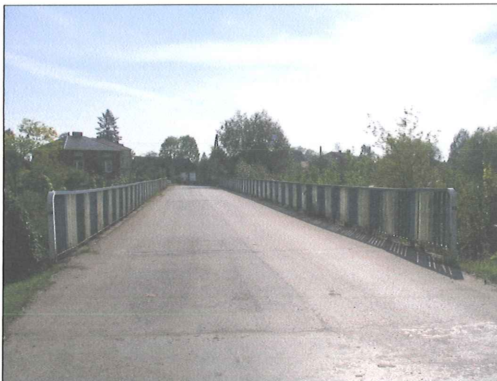
Fot. 3. Widok mostu z góry z widokiem dojazdu od strony DW nr 754.
