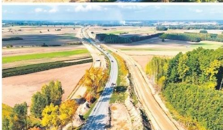
Budowa obwodnicy Ciepeliowa
