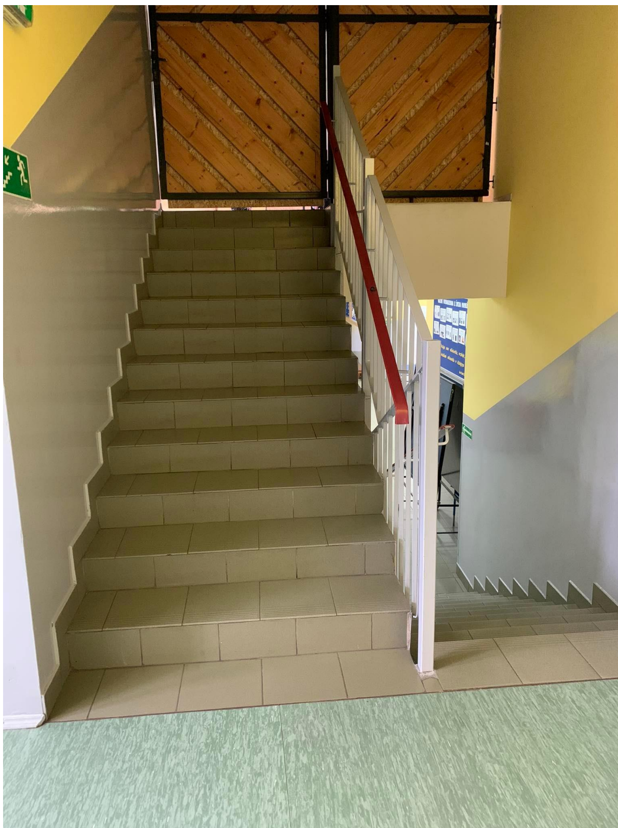
Zdjęcie piętra – schody na salę gimnastyczną z półpiętra górnego
