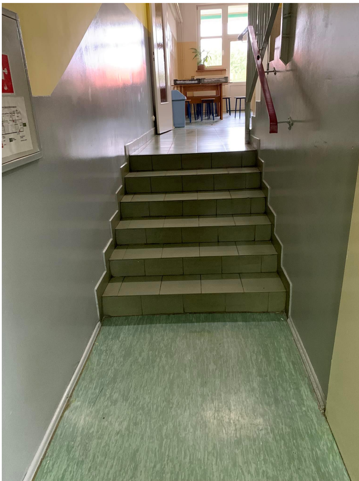
Zdjęcie schodów z piwnicy na półpiętro dolne (z szatni do stołówki)
