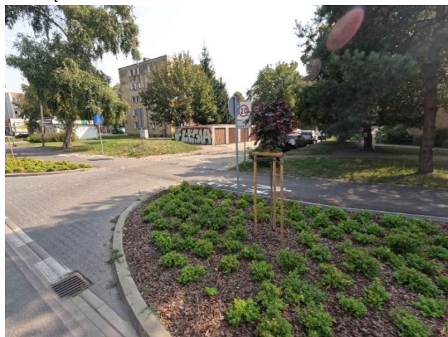
Fot. 49 Ciąg pieszo-rowerowy przy Al. Armii Krajowej w Wołominie
