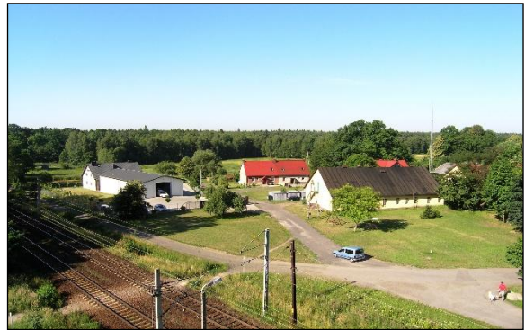
Fot. Widok „Dworu” z wiaduktu – 2008
