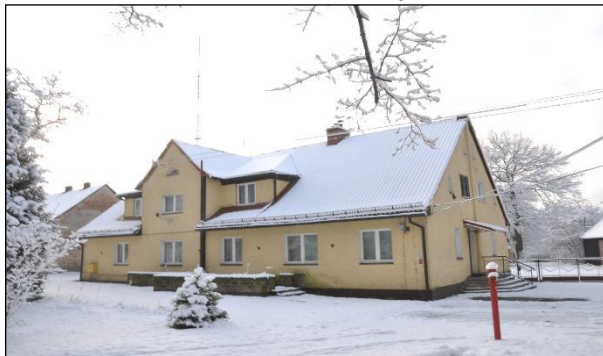
Fot. Wyburzona siedziba Nadleśnictwa Kobiór - zdj. z 2008r
