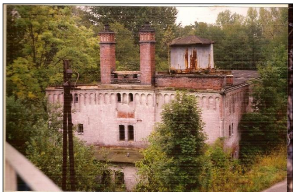
Fot. Wyburzona wyluszcznia nasion z 1905r. po wschodniej stronie torów kolejowych (fot. z 1992r.)
