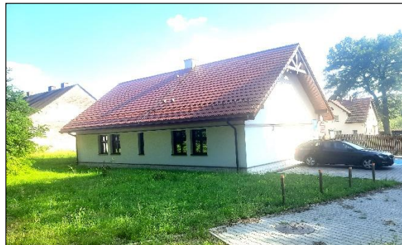
Fot. Nowa „Leśniczówka” w miejscu zburzonego budynku „Nadleśnictwa” - 2026
