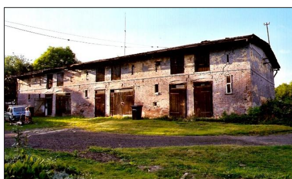
Fot. Budynek gospodarczy w „Dworze” wyburzony w 2002r. (teledysk „Zamyślane głowy”)
