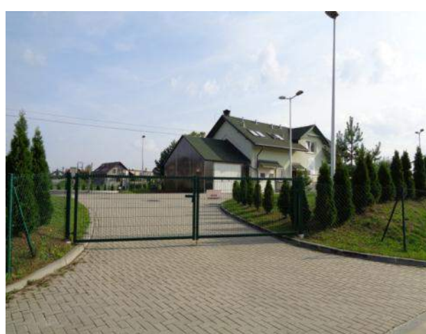
BUDYNEK OCZYSZCZALNI ŚCIEKÓW
