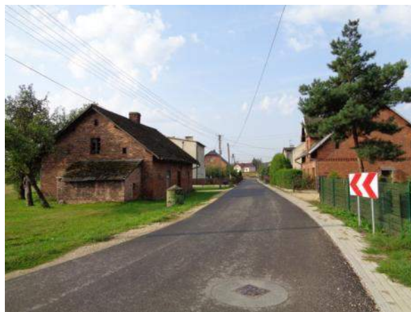
ZABUDOWA W REJONIE UL. WRÓBLEWSKIEGO
