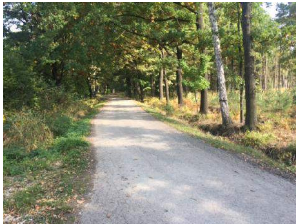
UL. PROMINCKA - WIDOK W KIERUNKU PÓŁNOCNYM
