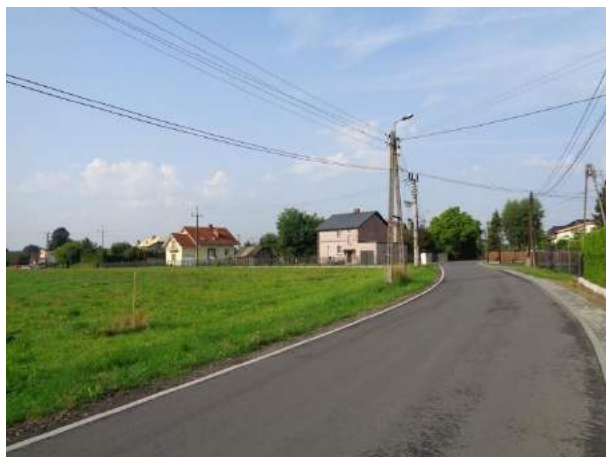
ZABUDOWA W REJONIE UL. WRÓBLEWSKIEGO
