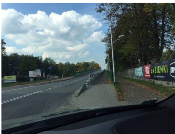
WIADUKT UL. CENTRALNEJ NAD LINIĄ KOLEJOWĄ
