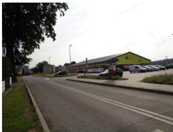
SKLEP "BIEDRONKA" PRZY UL. OŁTUSZEWSKIEGO
