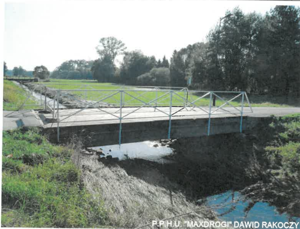
Zdj. 1 Widok na obiekt.
