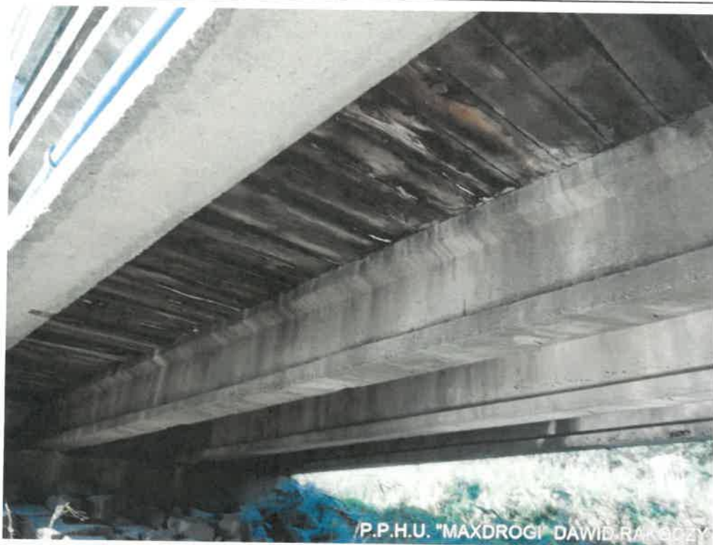
Zdj. 3 Widok na ustrój nośny.
