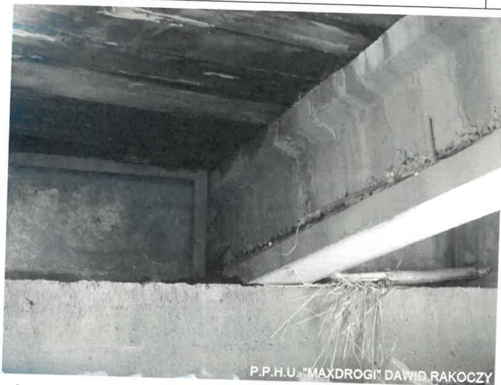
Zdj. 5 Zarysowania, korozja betonu, korozja zbrojenia dźwigarów ustroju nośnego.
