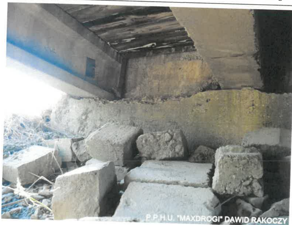
Zdj. 6 Ubytki betonu przyczółka w strefie podparcia.
