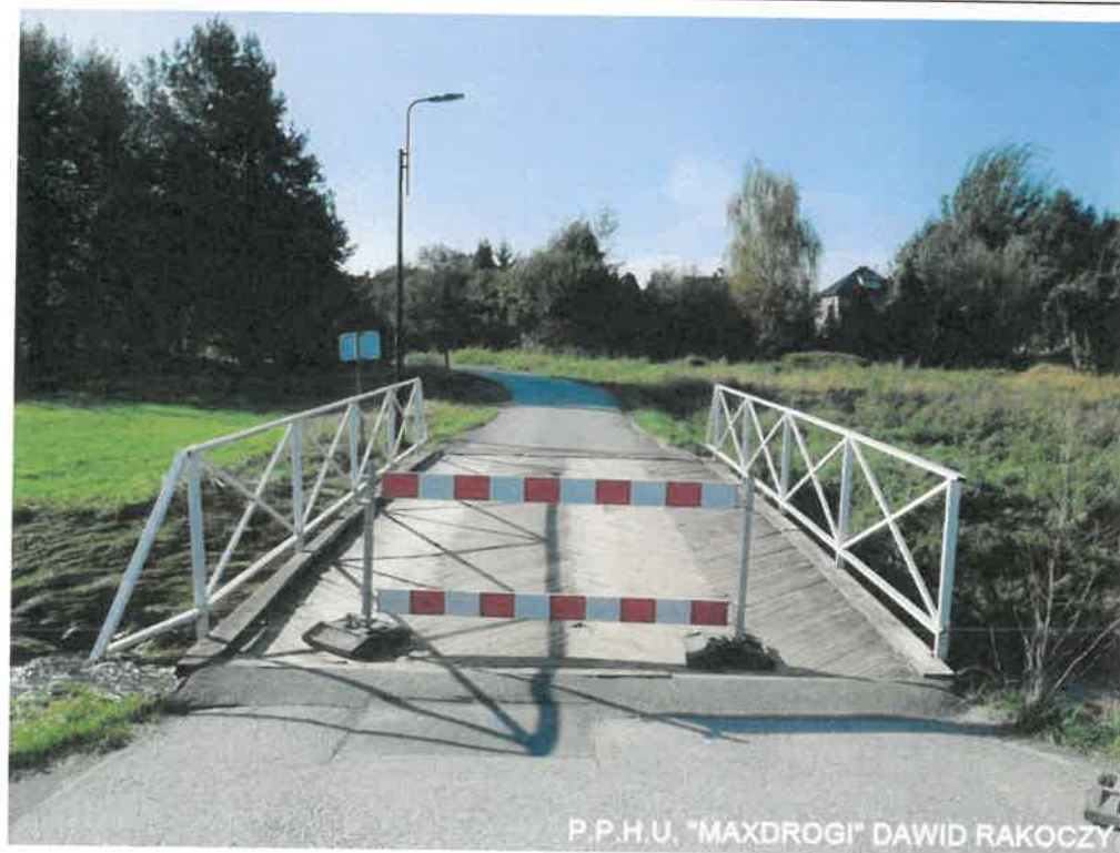
Zdj. 2 Widok na jezdnię na obiekcie.
