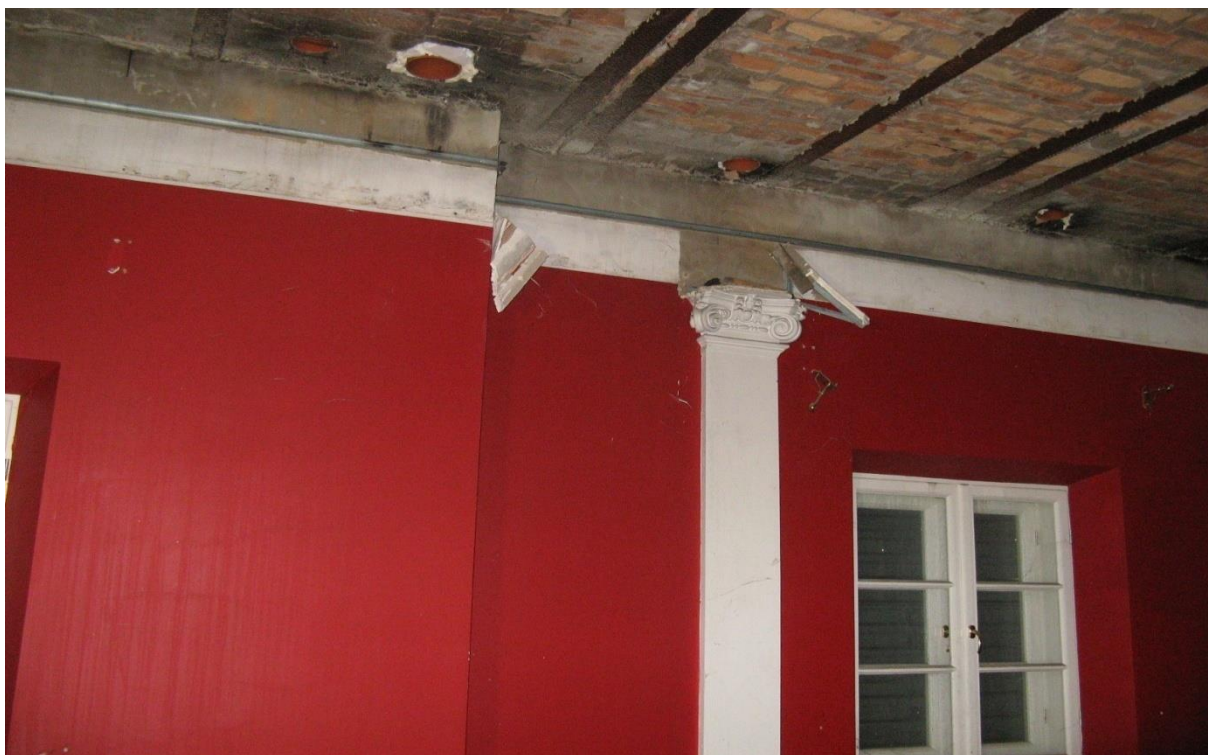
Uszkodzona głowica sztukaterii nad kolumną. Brak tynków na stropie Kleina
