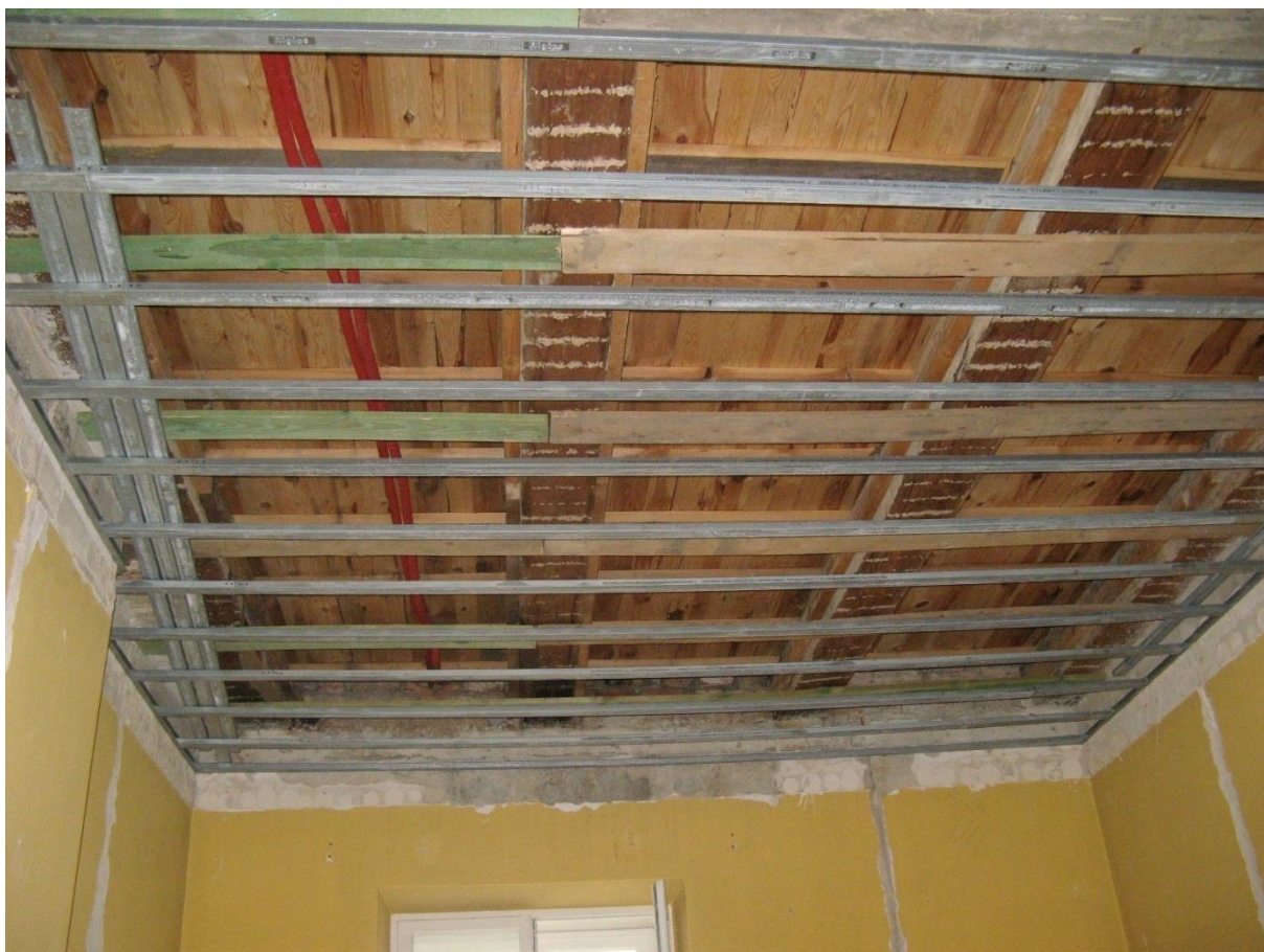
Stelaż stalowy do sufitu podwieszonego z płyt gipsowo-kartonowych
