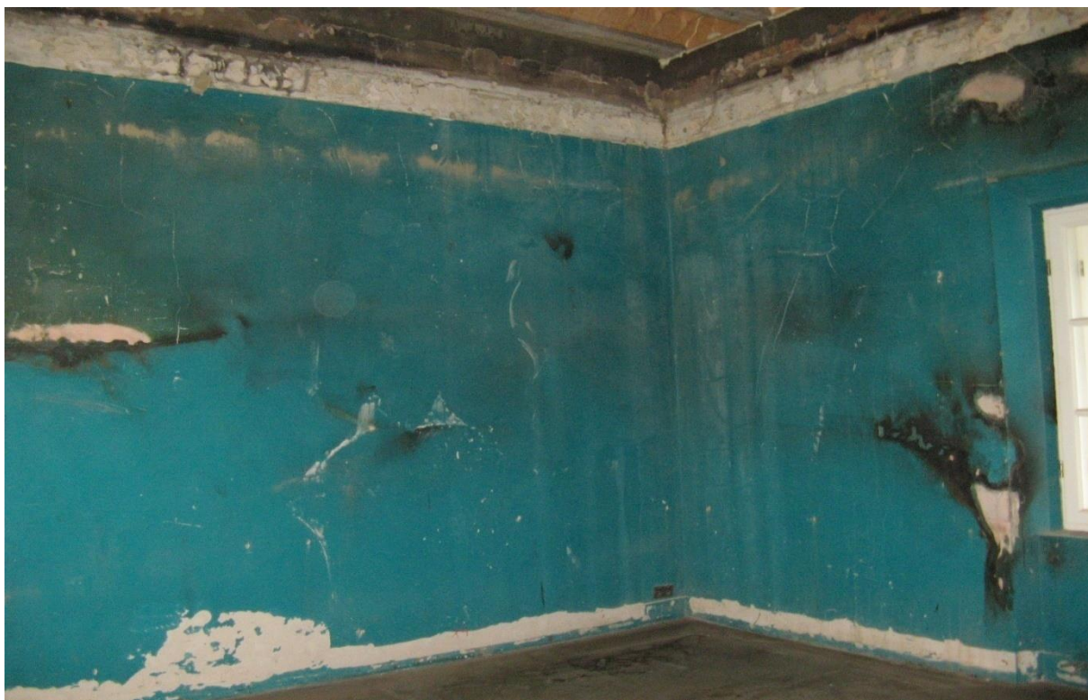
Zniszczone tynki wewnętrzne na ścianach po pożarze
