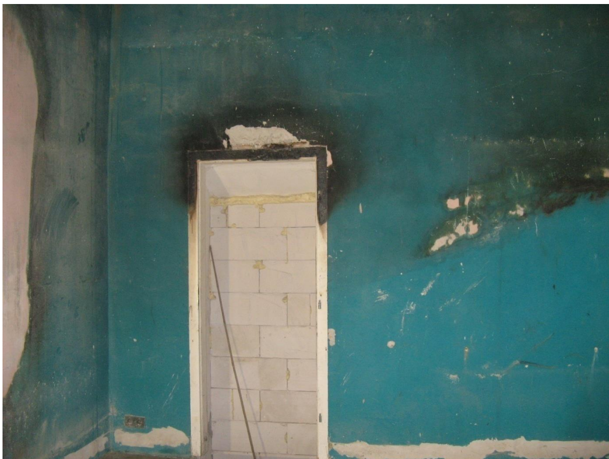
Zniszczone tynki wewnętrzne na ścianach po pożarze
