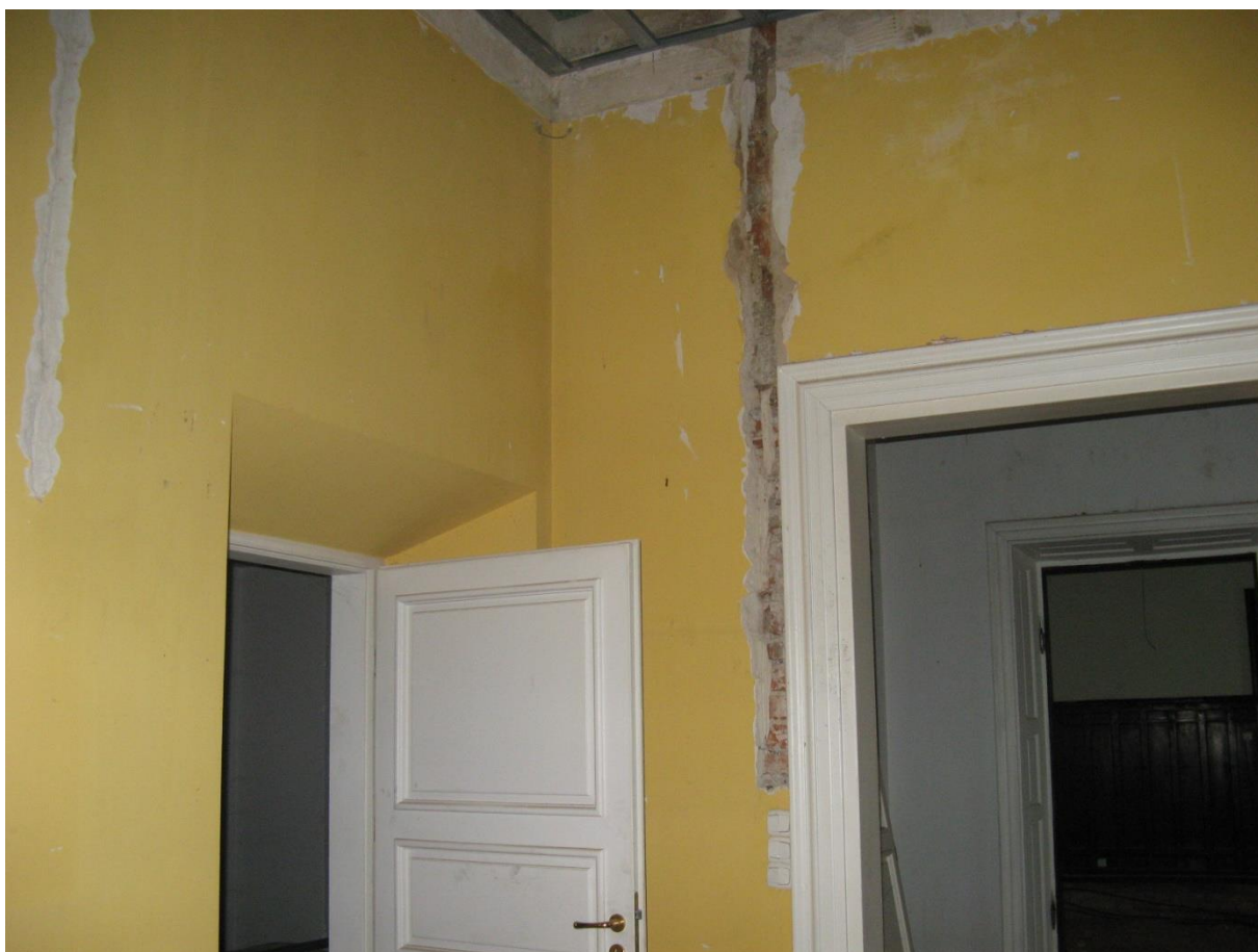
Bruzdy do robót elektrycznych
