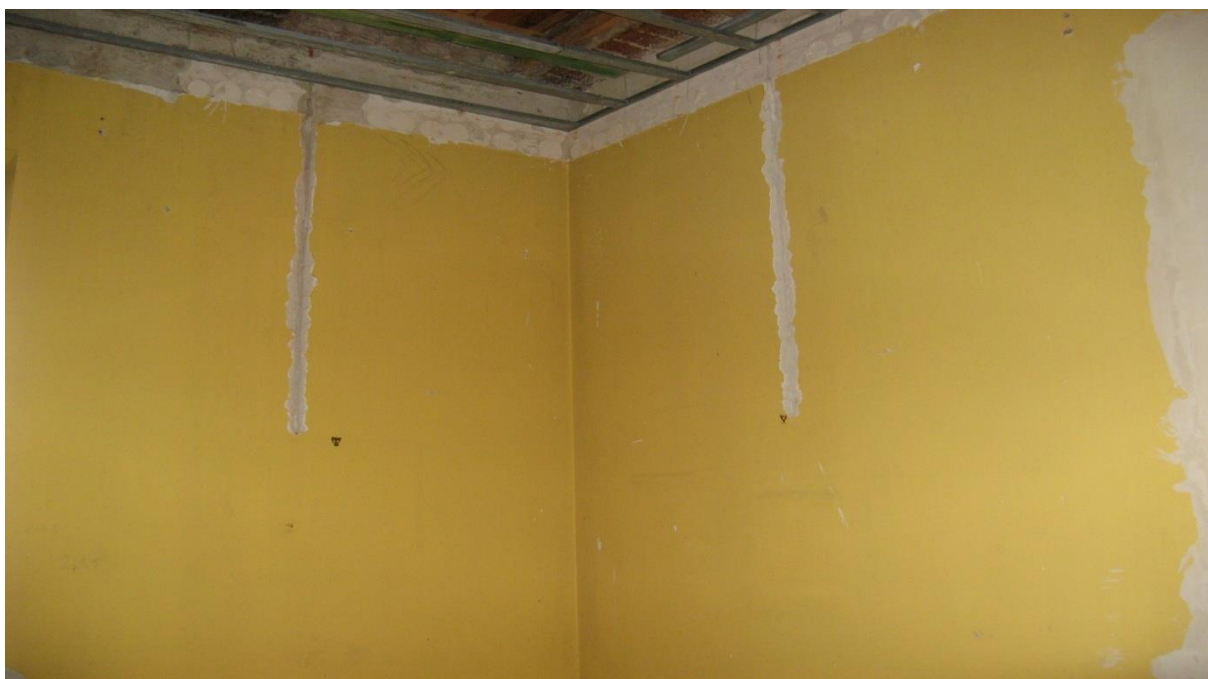
Bruzdy na ścianach do robót elektrycznych
