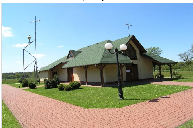
Fot. Budowa kaplicy pw. Świętego Antoniego z Padwy - (1998-2000); Wiele budowniczych z fotografii po lewej już od nas odeszło.
