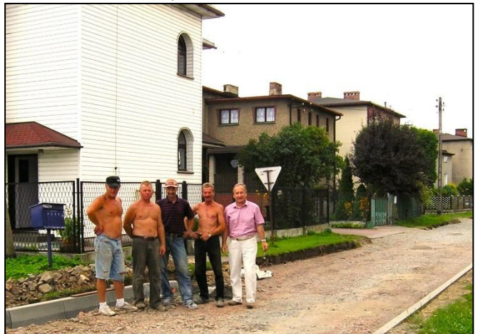
Fot. Roboty drogowe w tym samym miejscu po zakończeniu budowy kan. sanit. - 2011
