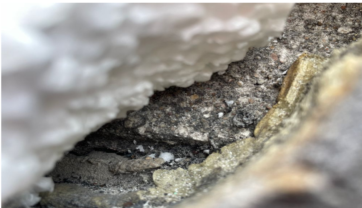
Przyziemie ubytek izolacji termicznej
