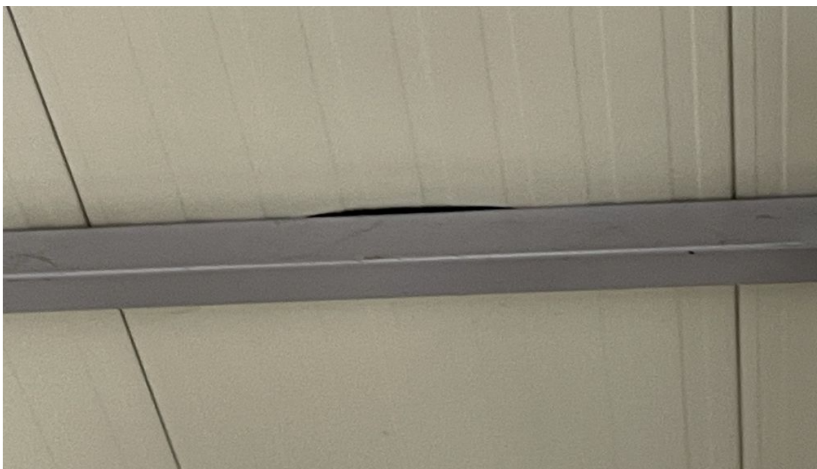
Miejsce łączenia połaci dachu z konstrukcją nośną – widoczny fragment folii izolacyjnej.
